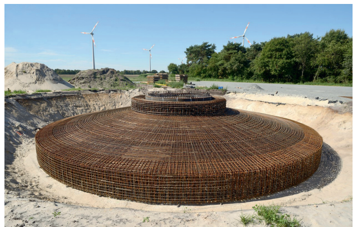
Stahlarmierung für ein massives Betonfundament
