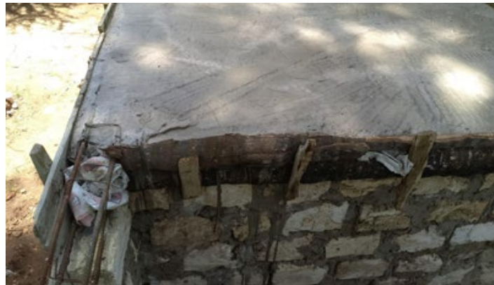
Inzwischen ist auch das Dach fertig, auf dem die Zisterne installiert werden soll.
