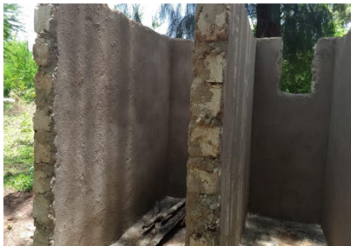
Die Wände der Toilette wurden mit eisenstangen verstärkt und verschalt.
